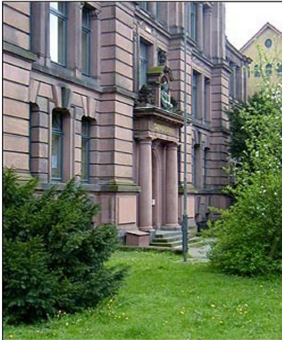
Eingangsportal der Sophienkirche („Hauptstelle“ in der Seelhorststraße)
